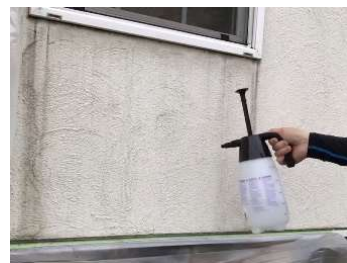
低圧スプレーやローラで 塗布します。
